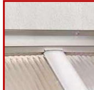
Schneiden Sie den Dichtgummi des Abschlusswinkels an den Profilen ein, damit er auf den Platten besser anliegt.
