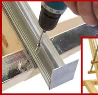
Vorbereitete Profilunterteile auflegen. Abschluss- und Haltewinkel können komplett überstehen (Wenn nicht möglich in den Sparren ausklinken). Profile exakt ausrichten, mit Zwingen fixieren und verschrauben.
