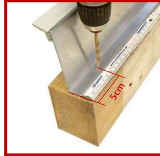
Bohren Sie den Alu-Wandanschluss. Der Bohrdurchmesser richtet sich nach den verwendeten Schrauben. Die erste Bohrung erfolgt nach ca. 5 cm, die folgenden Bohrungen immer in einem Abstand von ca. 40 cm.
