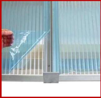
Legen Sie die Platte auf und richten Sie diese winkeltrecht aus. Plattenabstand 28 mm. Die gekennzeichnete Schutzfolie nach oben - UV-Schutz!
