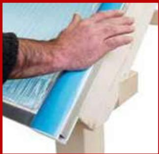
Nacheinander immer zwei Platten auflegen, ausrichten und fixieren. Profiloberteile Rand und Mitte auflegen und von einer Seite beginnend Stück für Stück einrasten. Bei 10 mm Platten in die zweite Nut (siehe folgende Skizzen)!
