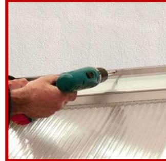
Verschrauben Sie das Profil mit geeigneten Schrauben.
