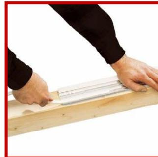
Ziehen Sie die Dichtlippen ein, falls diese noch nicht vormontiert sind. Die Schrägen müssen dabei nach außen gerichtet sein!.
