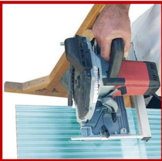
Schneiden Sie die Platten auf Endlänge. Berücksichtigen Sie hierbei einen ausreichenden Traufüberstand. Sägespäne in den Hohlkammern mit Druckluft oder Staubsauger entfernen. **Tipp:** Die Platten können auch auf Maß bestellt werden!
