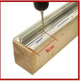
Profilunterteile im Abstand von 35 cm links und rechts vom Mittelsteg im Wechsel vorbohren (Ø 5 mm). Der Abstand der ersten Bohrung zur vorderen Kante beträgt 8 cm.
