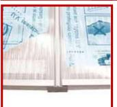
Legen Sie die Platte auf und richten Sie winkelgerecht aus. Plattenabstand 25 mm. Die gekennzeichnete Schutzfolie nach oben - UV-Schutz!
