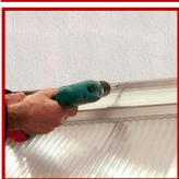
Verschrauben Sie das Profil mit geeigneten Schrauben.
