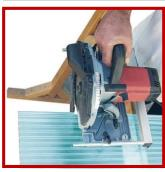
Schneiden Sie die Platten auf Endlänge. Berücksichtigen Sie hierbei einen ausreichenden Traufüberstand, Sägespäne in den Hohlkammern mit Druckluft oder Staubsauger entfernen. Tipp: Die Platten können auch auf Maß bestellt werden!
