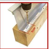
Bohren Sie den Alu-Wandanschluss. Der Bohrdurchmesser richtet sich nach den verwendeten Schrauben. Die erste Bohrung erfolgt nach ca. 5 cm. die folgenden
