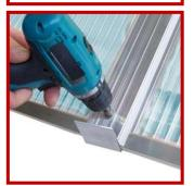
Nacheinander immer zwei Platten auflegen, ausrichten und fixieren. Profiloberteile Rand und Mitte auflegen und Edelstahlschrauben (Metall6,3x 32 mm) oder Bohrschrauben (5,5 x34 mm) mit dem Unterteilen verschrauben. Fortfahren Bis zur letzten Platte. Diese dann einmessen, ggf. zuschneiden und mit Randprofil montieren.
