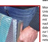
Montieren Sie dann an der Unterseite (Traufe) die Alu-U-Abschlussprofile mit Tropfnase nach unten. Die Schutzfolie wird dabei nur soweit entfernt wie es zur Befestigung nötig ist.
