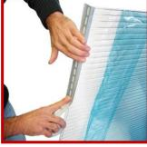
Verschlussband am Ende der Platte an. Es verhindert das Eindringen von Staub, Schmutz und Insekten. Die Membranversion lässt gleichzeitig die Lüftung der Hohlkammern zu.
