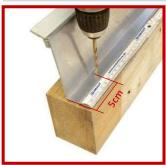
Bohren Sie den Alu-Wandanschluss. Der Bohrdurchmesser richtet sich nach den verwendeten Schrauben. Die erste Bohrung erfolgt
