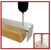
Legen Sie den Abschluss- und Haltewinkel an der Unterseite des Unterprofils so an der Kante an, dass der Wasserablauf frei bleibt (siehe Bild). Bohren Sie nun das Unterprofil 2 mal (Ø 3,5 mm) vor. Befestigen Sie anschließend den Winkel mit 2 Edelstahlschrauben (4,2 x 16mm) am Unterprofil.
