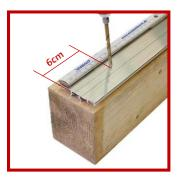
Profiloberteile im Abstand von 40 cm mittig vorbohren (Ø 7 mm). Der Abstand der ersten Bohrung zur vorderen Kante beträgt 6 cm.
