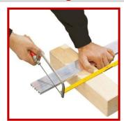
Ermitteln Sie die genaue Endlänge der Profile. Falls erforderlich mit einer Metallsäge kürzen.
